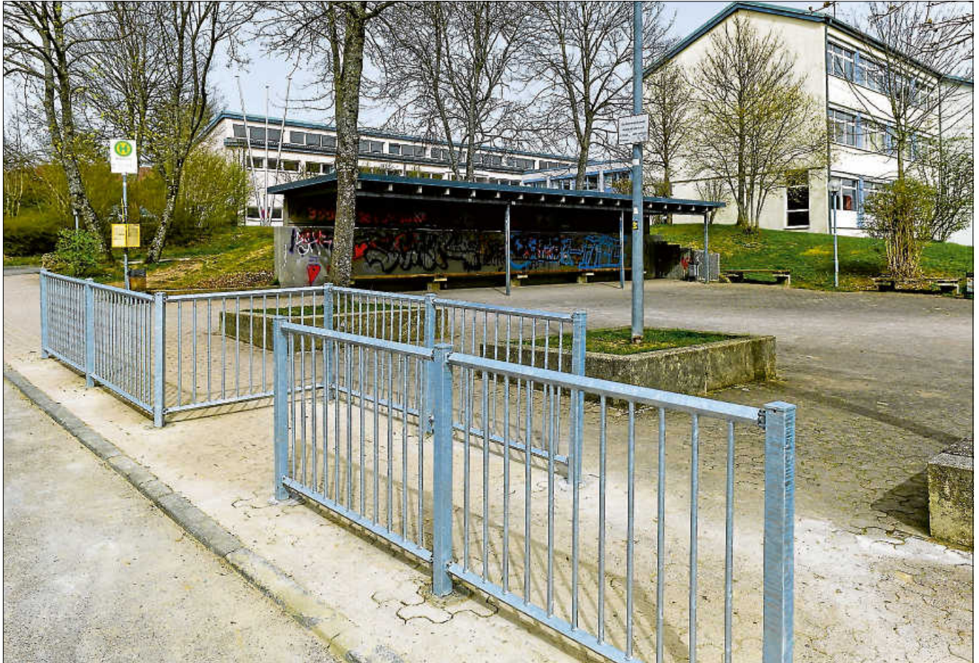
Drängelgitter als Sicherheitsbarriere an der Bushaltestelle.
